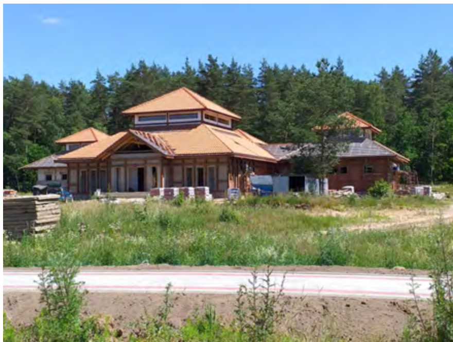
Pawilon uzdrowskiowy w trakcie budowy. Fot. Archiwum Gminy Górowo Iławeckie
